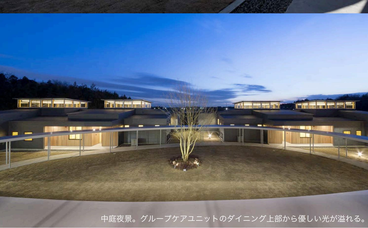
中庭夜景。グループケアユニットのダイニング上部から優しい光が溢れる。
