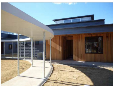
棟・ユニット外観
